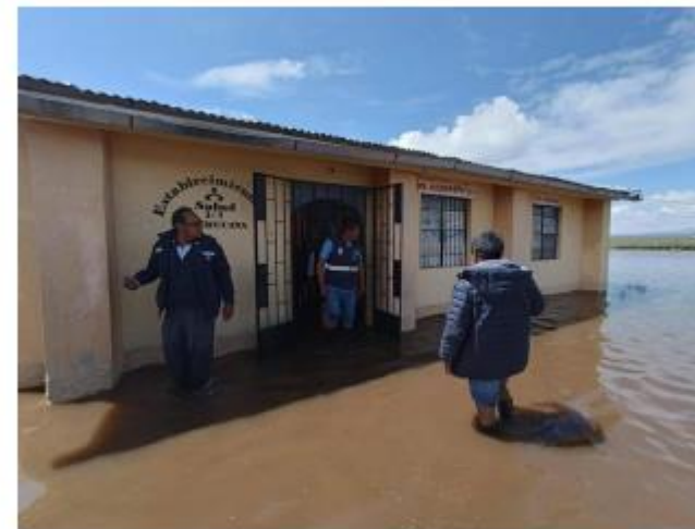
IMAGEN 1: GOBERNADOR REGIONAL SUPERVISANDO DAÑOS A LA INFRAESTRUCTURA DEL EESS CARUCAYA
