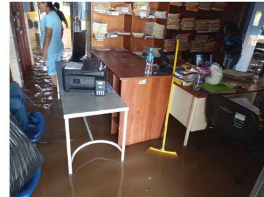
IMAGEN 2: AFECTACION DE AMBIENTES DEL EE.SS
