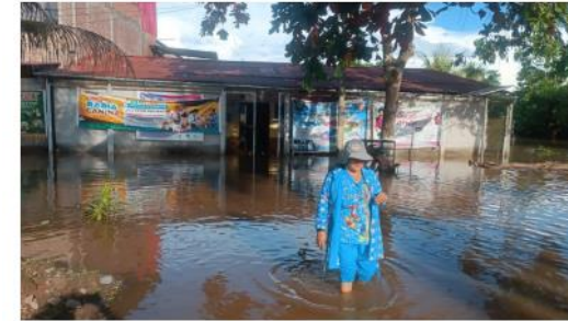
IMAGEN 1: EXTERIOR EL EE.SS
